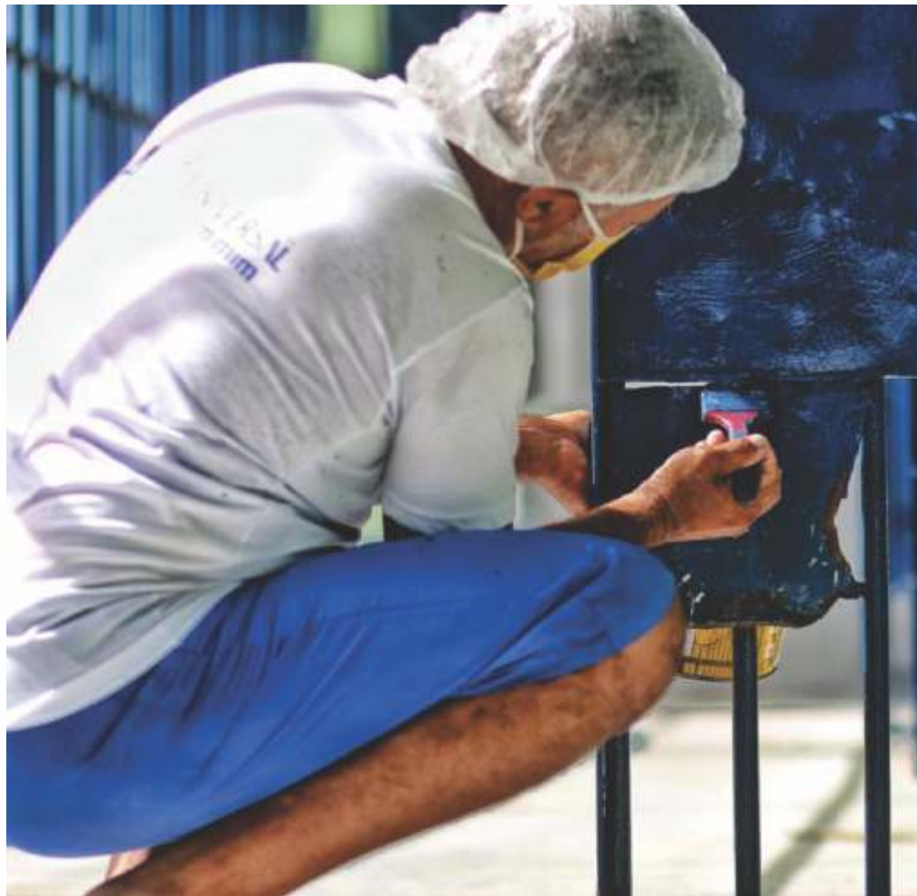
► Reformas feitas por detentos mudam realidade de Penitenciárias do Piauí.
